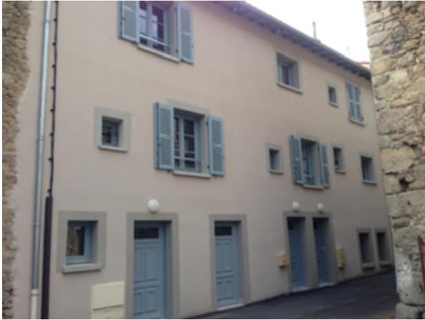
Figure 9 : Immeuble sur les parcelles 275 et 276, façade arrière avec entrée privative pour chaque logement (source CEREMA, Juliette Goux)
