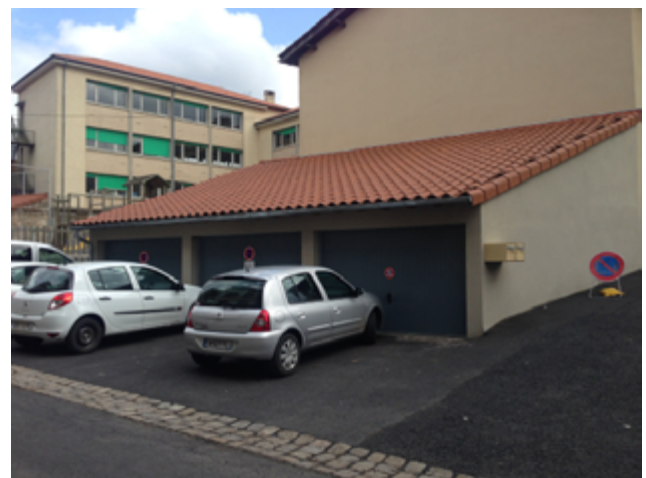
Figure 11 : Construction « adossée » contre le bâtiment mitoyen (crédit photo, CEREMA, Juliette Goux)
