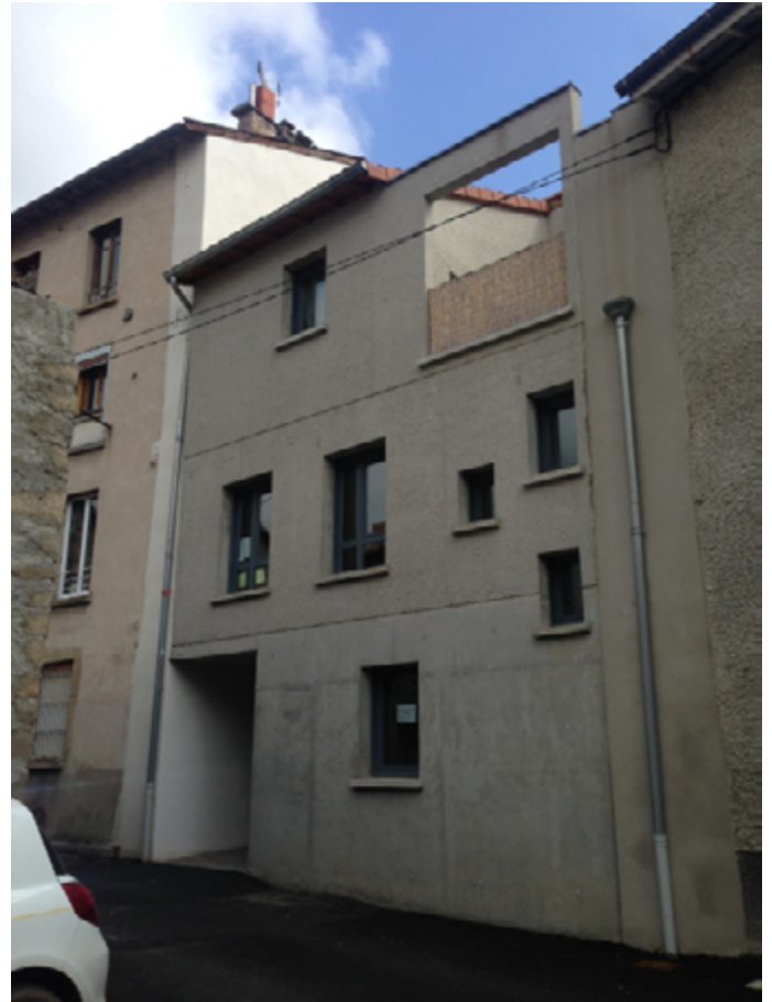
Figure 10 : Immeuble rue des Dragons / rue Pannessac, avec le percement permettant un passage piéton entre les deux rues (crédit photo CEREMA, Juliette Goux)
