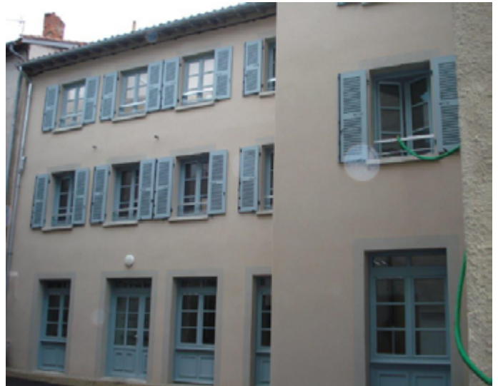
Figure 8 : Immeuble sur les parcelles 275 et 276, façade rue centrale, après travaux. Derrière les fenêtres du troisième niveau, se cachent des terrasses privatives, insoupçonnables depuis la rue (source CEREMA, Juliette Goux)
