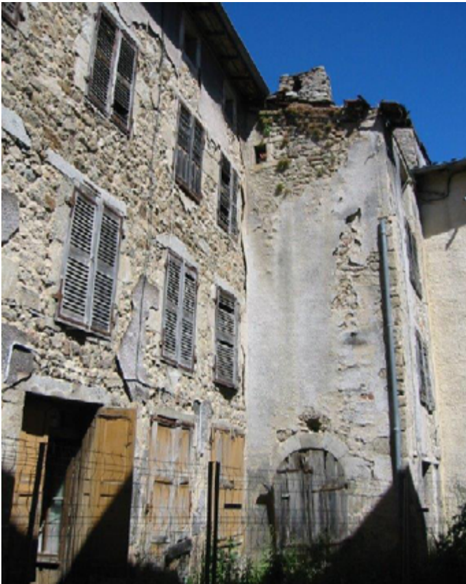
Figure 7 : Immeubles des parcelles 275 et 276 avant démolition (source CEREMA, Juliette Goux)
