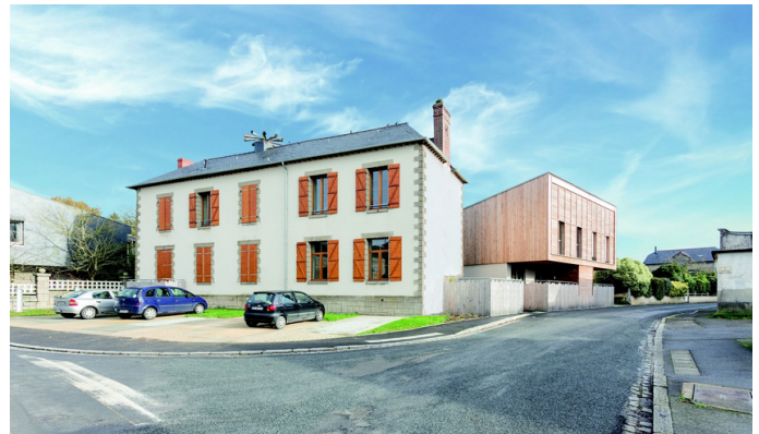
Figure 1 : Le programme de logements construit à partir de l'ancienne mairie Mairie (source : site internet Territoire / crédit : C. Gosselin)
