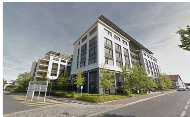
ZAC Fort d'Issy (Issy les Moulineaux) Piscine de la ZAC. Eiffage Energie
