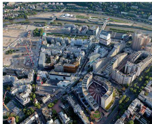
ZAC Seguin-Rives de Seine (Boulogne-Billancourt) Système chaud / froid par IDEX / Réalisation Eiffage Energie
