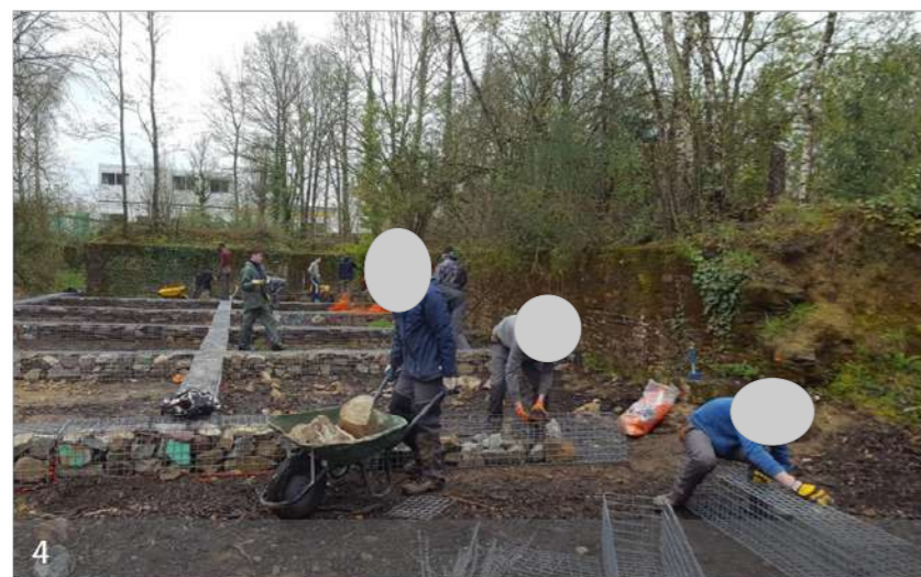
3- Remplissage des gabions
