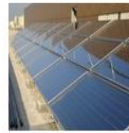
Climatisation et eau chaude solaire 120 MWh / an
