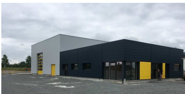
Construction d'un bâtiment industriel
