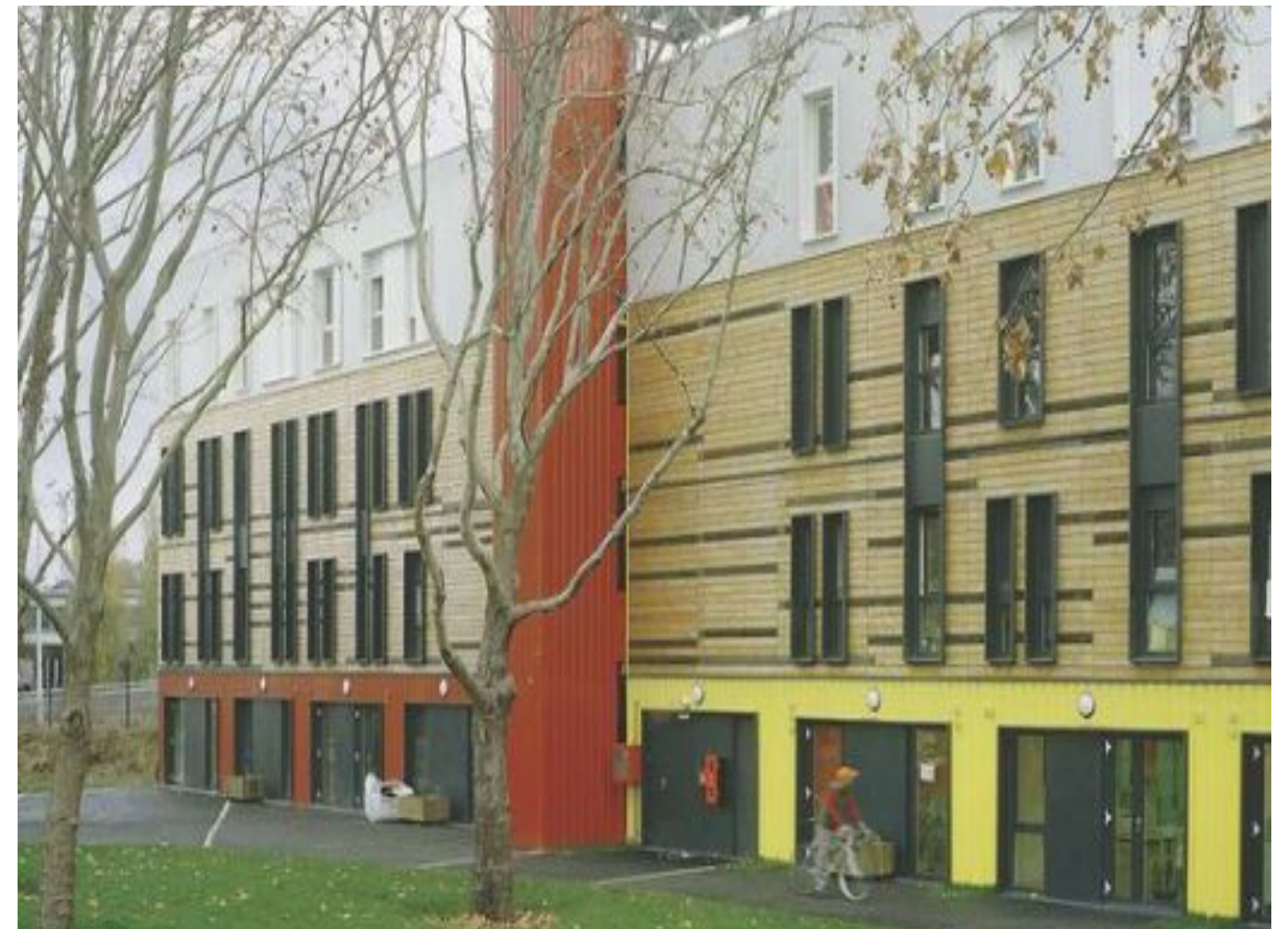
Bastion de Bercy - Centre d'hébergement d'urgence en préfabriqué - Association Aurore, Paris 12ème
