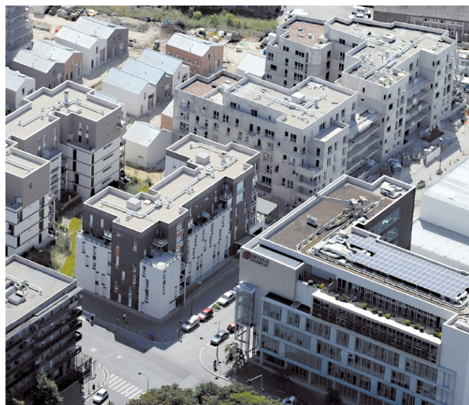
Figure 1 : Vue aérienne du projet (Crédit image : Eiffage aménagement)
