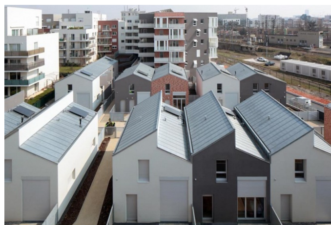
Figure 7 : 70 logements Architecte : Petitdidier Prioux Architectes, Sébastien Perrault (chef de projet) Crédit photo : Stephan Lucas
