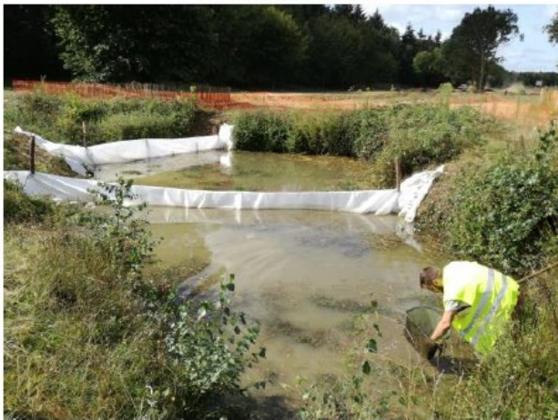
Photo 6 : Barrières de protection en géotextile installée et pêche de sauvegarde
