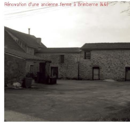
Rénovation d'une ancienne ferme à Brimberne (44)
