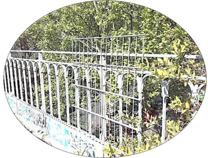
Mise au normes du garde corps historique existant par ajout d'une serrurerie avec remplissage maille rectangulaire : Test de matériaux in situ
